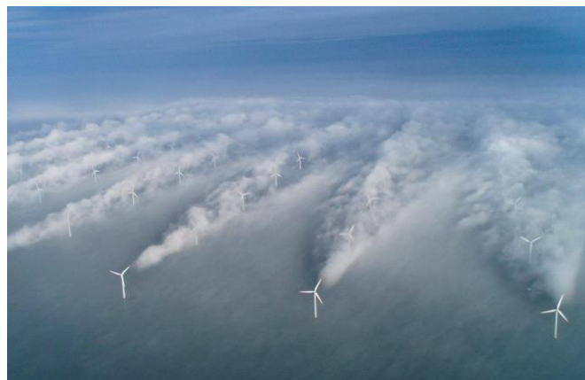
Horns Rev 洋上風力発電所(デンマーク)
